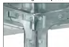
Aussteifung mit Eckplatten
